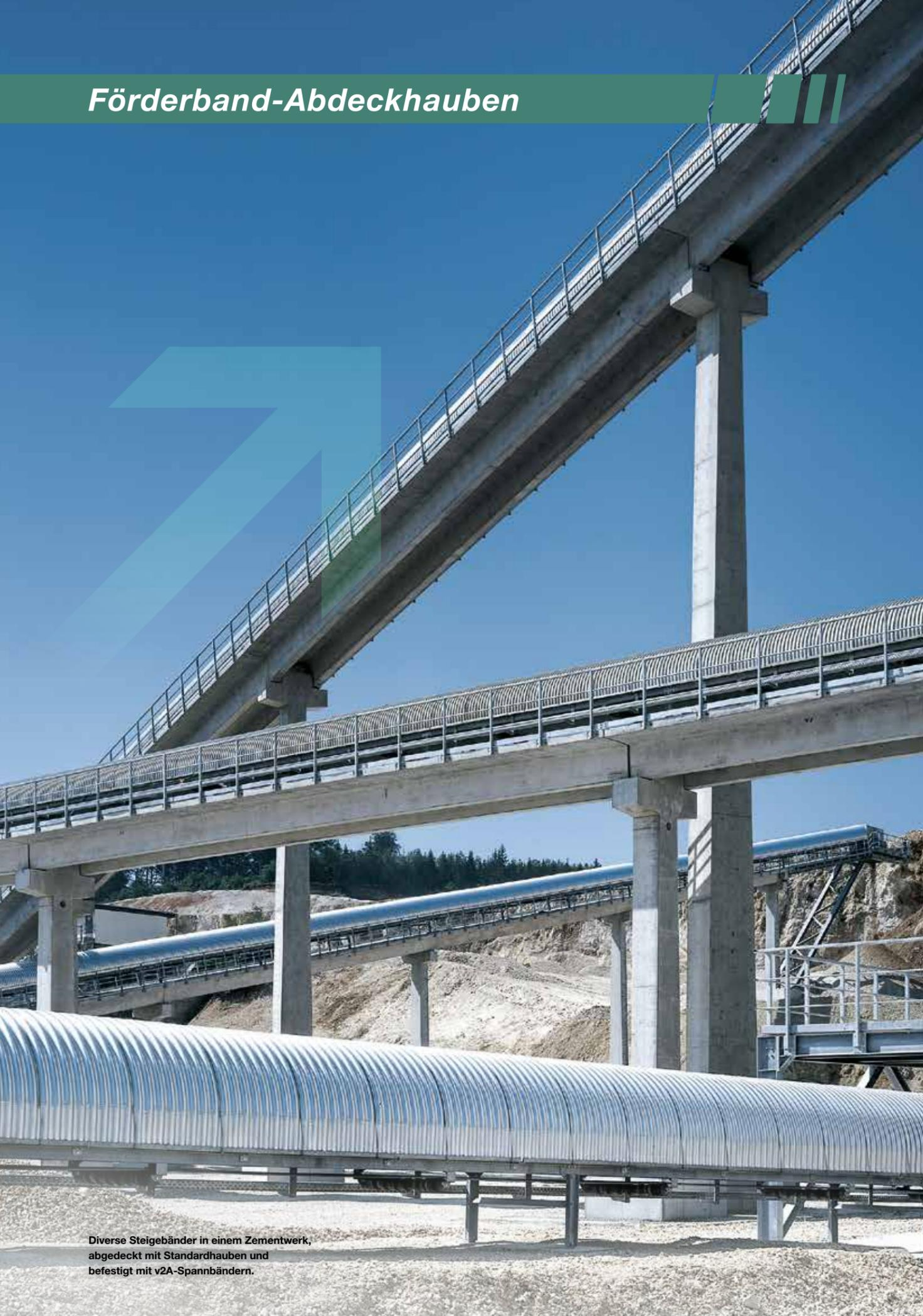
Diverse Steigebänder in einem Zementwerk, abgedeckt mit Standardhauben und befestigt mit v2A-Spannbändern.
