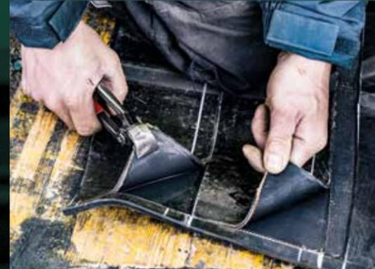
Im Verbindungsbereich werden der Gummi und das Gewebe in Stufen eingeschnitten und abgezogen.
