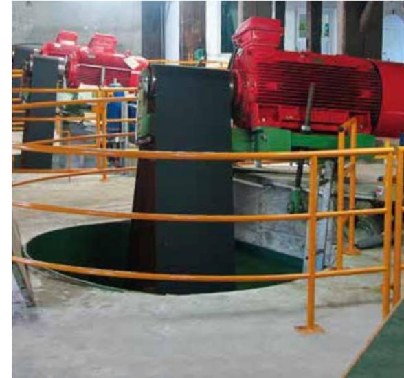
Generatorantrieb einer Kaplan-Rohrturbine. Turbinenleistung 240 kW.
