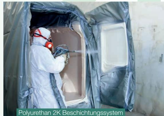
Polyurethan 2K Beschichtungssystem im Sprühverfahren in den verschiedensten Anwendungsbereichen. Vom Firmenfuhrpark, über Industrietelle bis hin zur Architektur.
